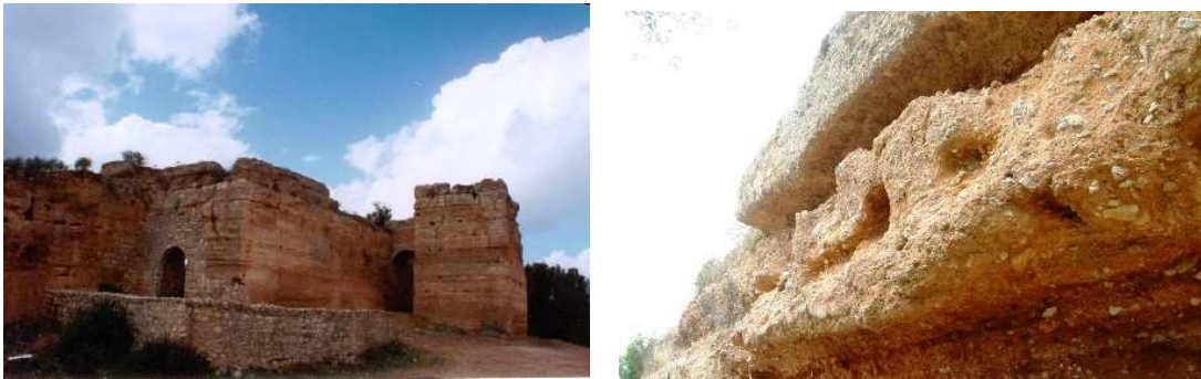
Figura 1: Alguns pormenores das muralhas do Castelo de Paderne.
